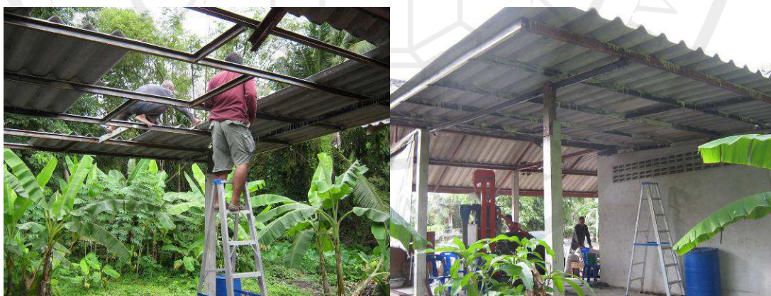
ภาพประกอบ 12 เชื่อมหลังคาเดิมและหลังคาใหม่ที่ทำการต่อเติม
