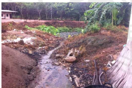
ภาพประกอบ 22 ทางระบายน้ำเสีย
