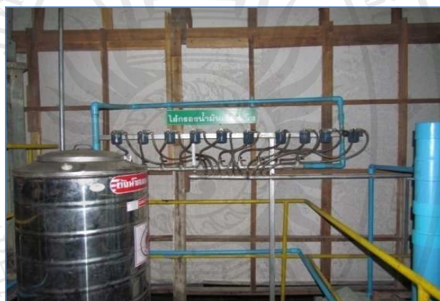
ภาพประกอบ 37 ระบบกรองผ่านไส้กรอง ก่อนนำไปใช้งาน
