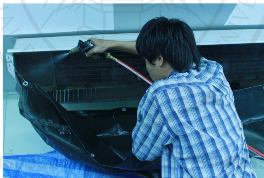
ภาพประกอบ 18 การฉีดล้างทำความสะอาดแผงคอยล์เย็นด้วยเครื่องฉีดน้ำแรงดันสูง
